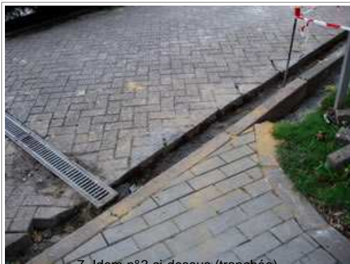
7. Idem n°3 ci-dessus (tranchée)
