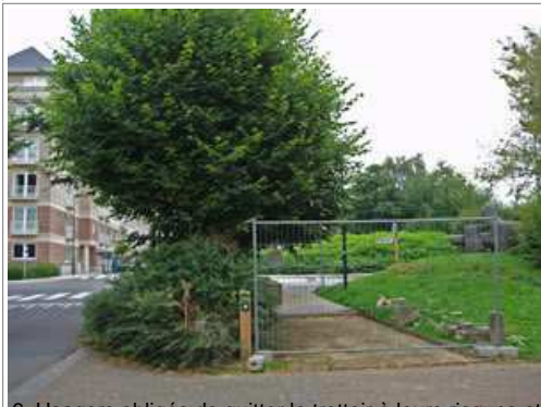
6. Usagers obligés de quitter le trottoir à leurs risques et périls
