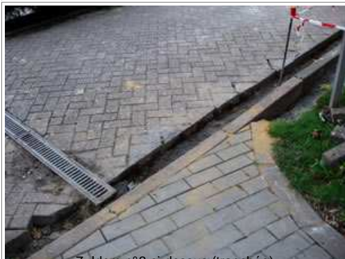
7. Idem n°3 ci-dessus (tranchée)
